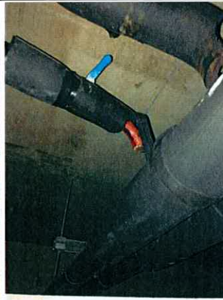
Parties de réseaux sectionnées pour stopper les problèmes de condensation
