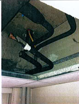
Parties de réseaux sectionnées pour stopper les problèmes de condensation
